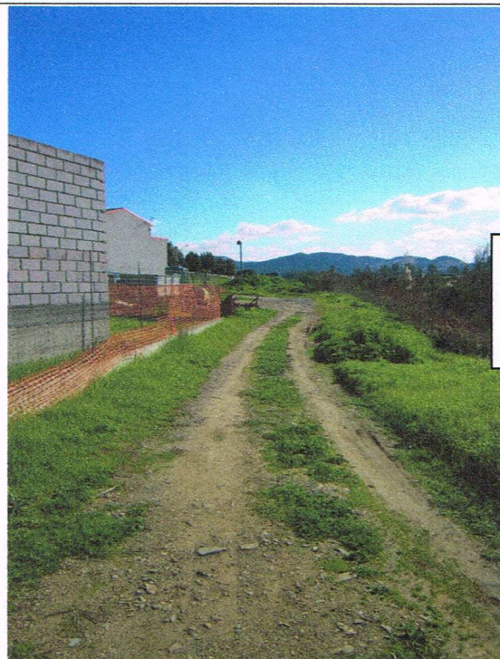
Figura 3: Sullo sfondo la via di connessione tra la via Tirso e la via Coghinas nell'area P.E.E.P. di Santadi Basso, oggetto dell'intervento di urbanizzazione primaria. VISTA sud
