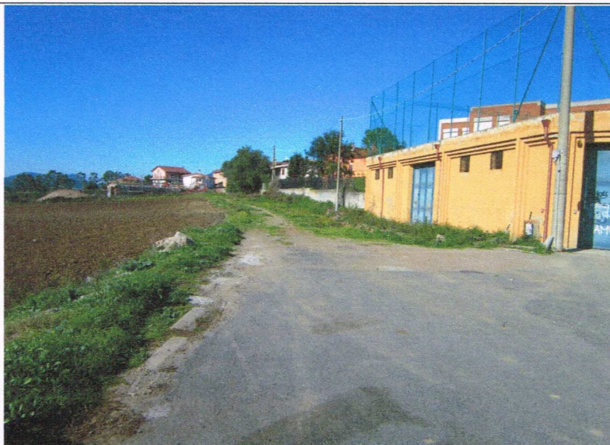
Figura 1: Tratto di via Cavour non bitumato oggetto dell'intervento a Santadi Centro.
